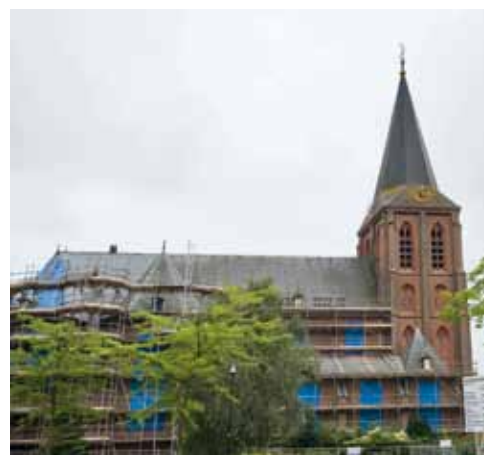
■ De St. Victorkerk in Benschop heeft in 2009 een aanvullende subsidie vanuit het Parelfonds gehad voor de renovatie.
